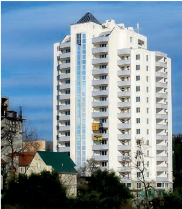
70-ти квартирный жилой дом со встроенными офисами по ул. Пионерской, 14 в г. Сочи, 2002 год
