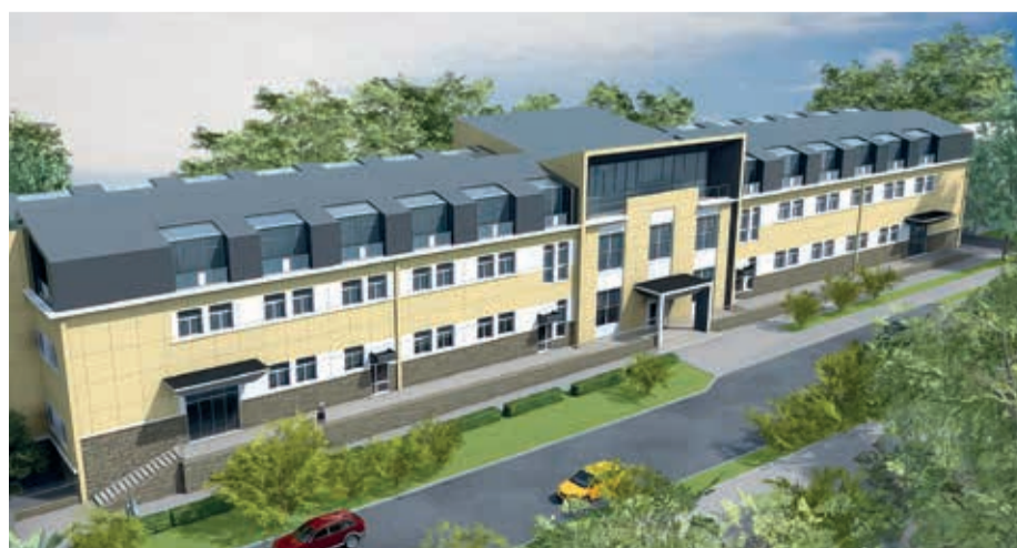
Административное здание ООО «РУСКО» по адресу: г. Сочи, ул. Черноморская, 15, реконструкция, 2013 год.
